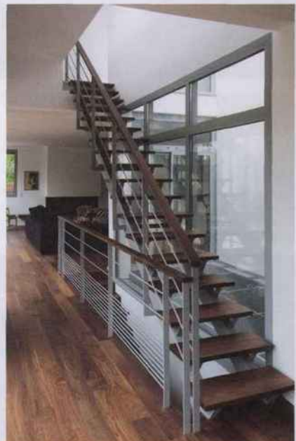
Parquet et escalier sur-mesure - Noyer étuvé vernis mat
